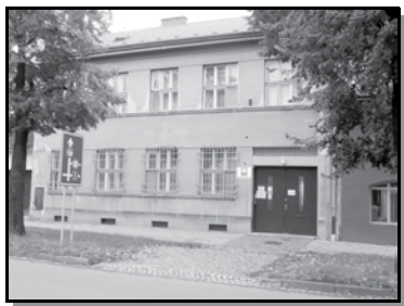
Sídlo ředitelství Charity Kojetín Adresa: Kroměřížská 198, Kojetín
